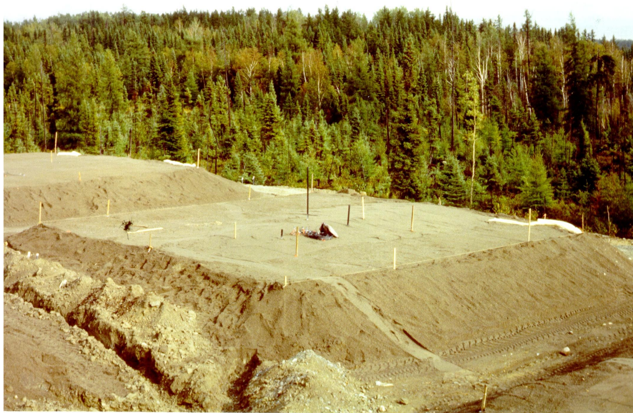
Photographie 4.11 Vue d'une cellule à la fin des travaux de construction
