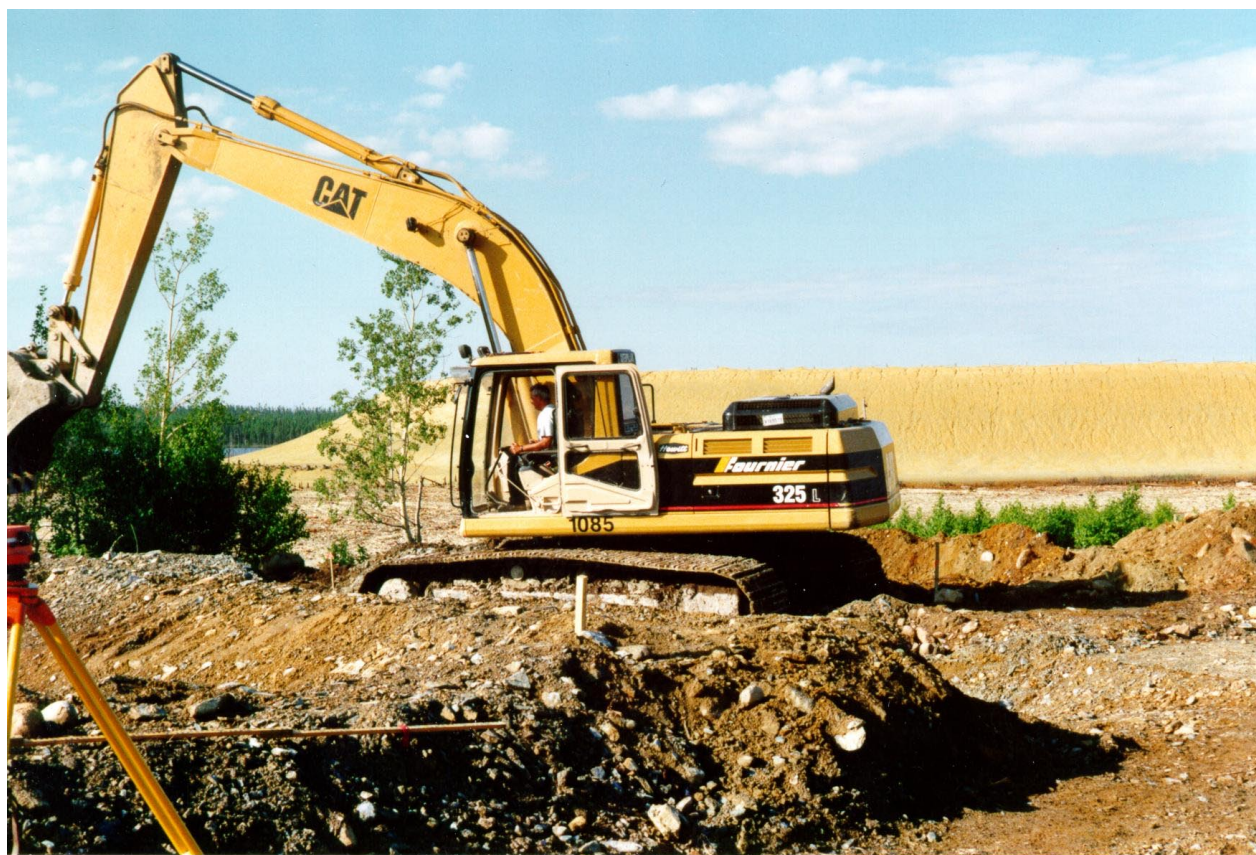
Photographie 4.1 Excavation de la forme des cellules dans le stérile (site Manitou)
