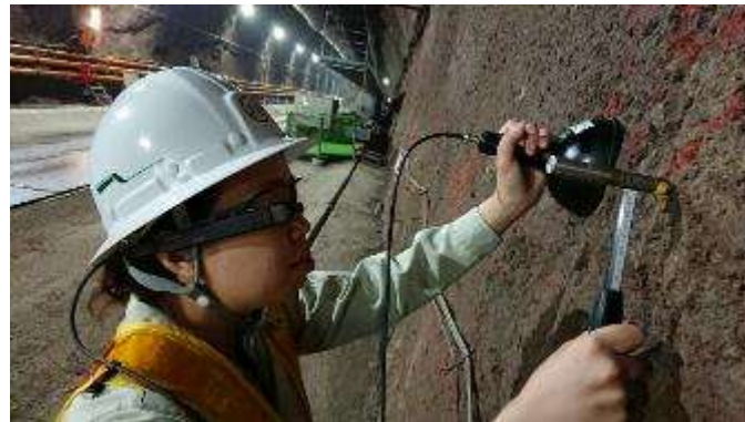
実際の作業の様子
