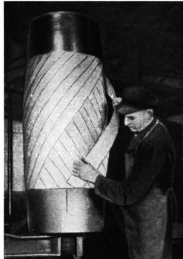
Bild 936. Einstecken der Schälholzstreifen um den Preßkern zur Herstellung eines bauchigen Sperrholzfasses.
