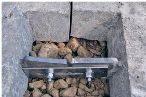
Контактные элементы и стальные полосы для соединения экранов
