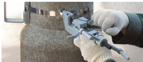
Замок на смонтированном хомуте из монтажной ленты
