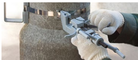
Замок на смонтированном хомуте из монтажной ленты
