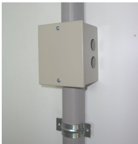
Трубы 50 мм соединённые в коробке КРУ-1
