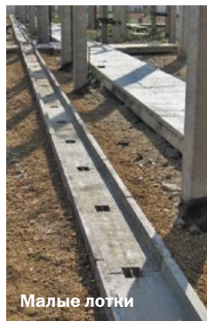
Переход малых лотков через существующую канализацию
