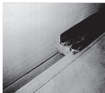
③ソーカンパックをきつめに詰め込み、アルミテープをスラブと外壁に貼る。
