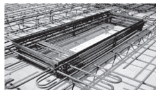
③ ガイザー板施工例
