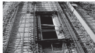
④ FR板施工例
