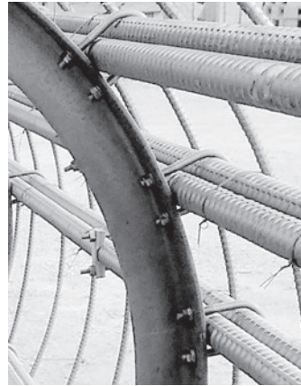
かご筋の主筋と補強リングをUボルトにより固定。
