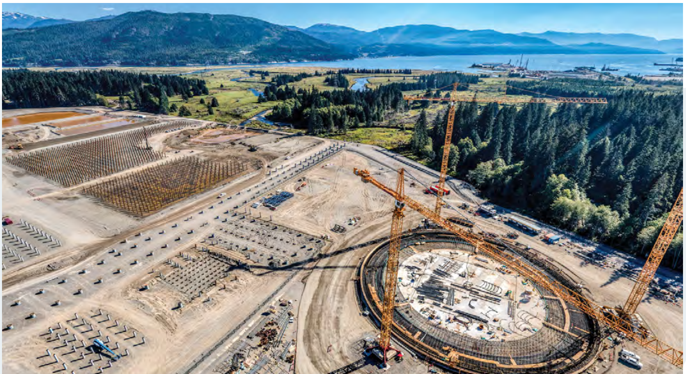
LNG tank pad at the LNG Canada site in Kitimat, British Columbia, Canada. Photo courtesy of LNG Canada.
