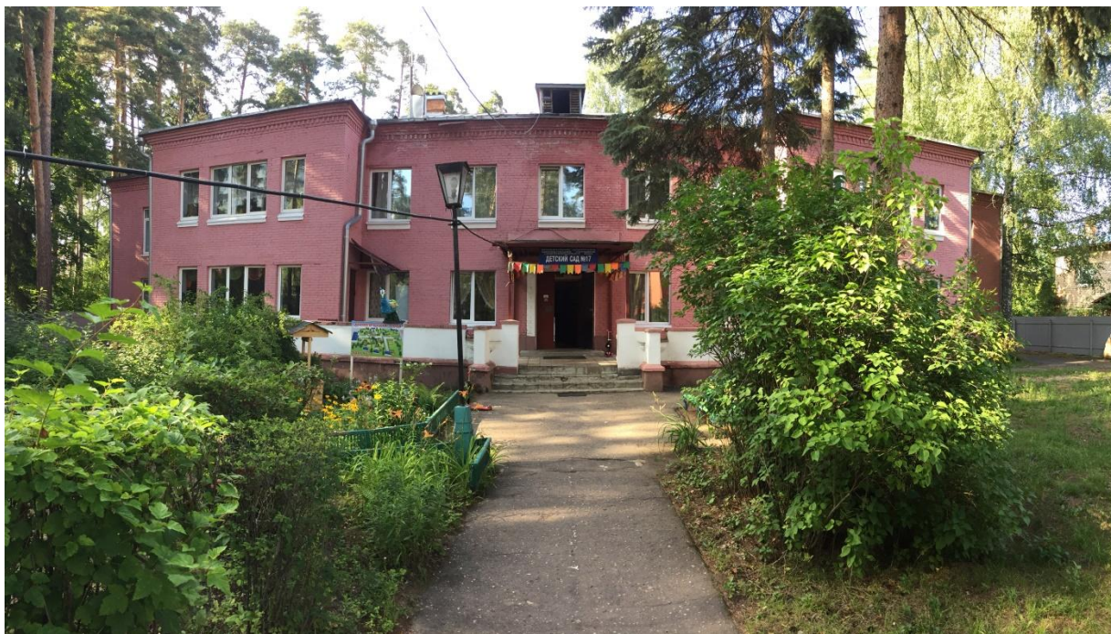
№1 Общий вид обследуемого объекта
