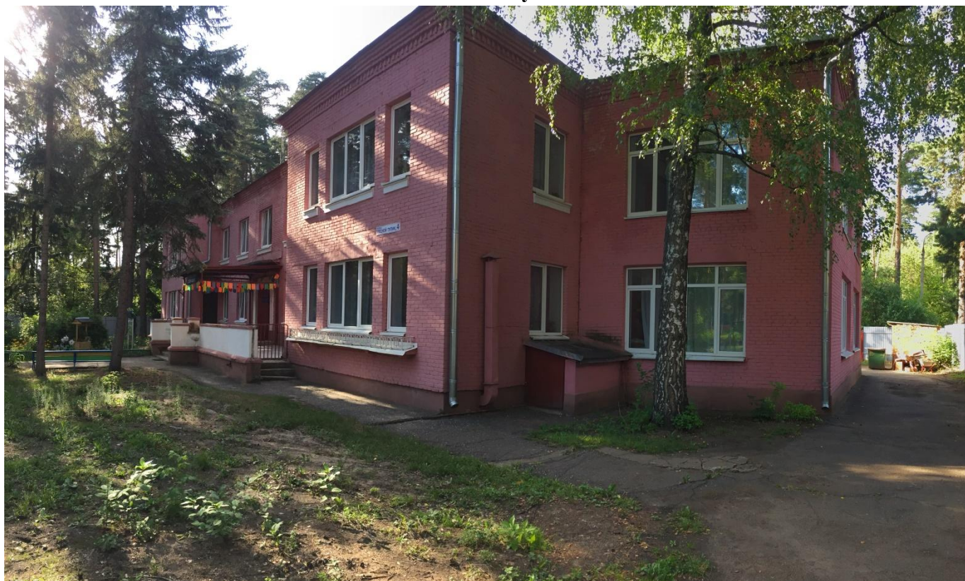
№2 Общий вид обследуемого объекта
