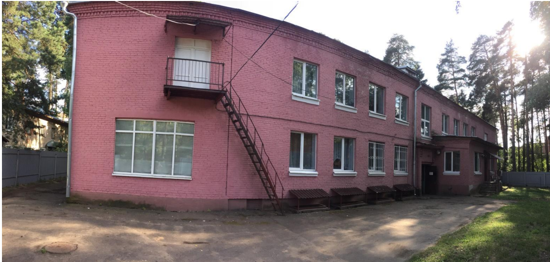
№3 Общий вид обследуемого объекта
