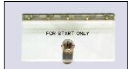
ESCALATOR FIXTURE DOOR
