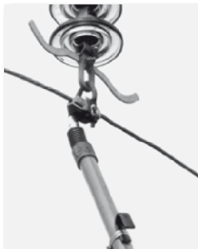
Blocage d'un écrou Tightening of a nut
