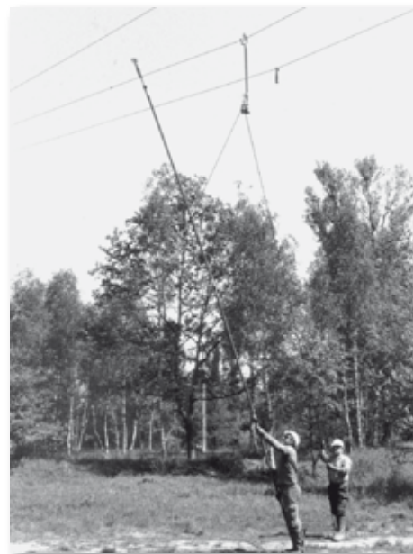
Pose d'une MAGS sur une phase extérieure Laying of AGL on an external phase
