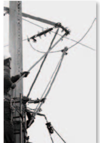
Immobilisation d'un pont Immobilisation of a jumper
