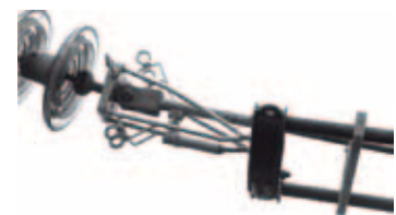
Reprise de la tension mécanique d'un conducteur Taking up the mechanical tension of a conductor
