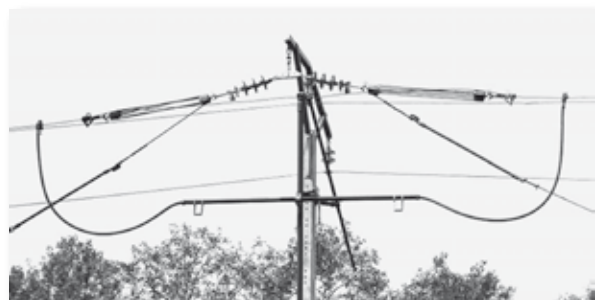
Mise en place de deux palans pour mettre en double ancrage un conducteur en alignement
