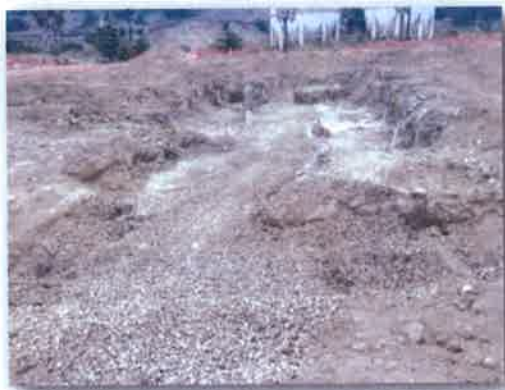
Coarse Gravel Fill
