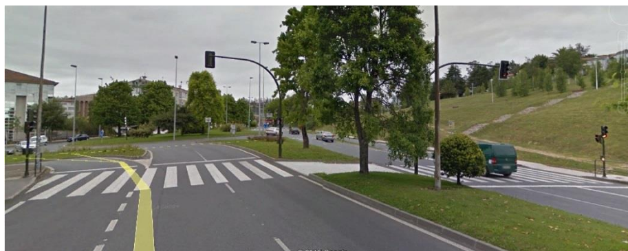
PASO DE PEATONES EN N-634
