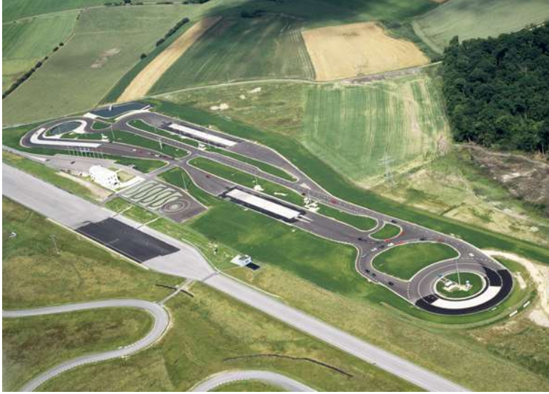
FIGURE 3.18: Centre de Formation pour Conducteurs S.A., Colmar-Berg, Luxembourg (Schroeder, 2016)
