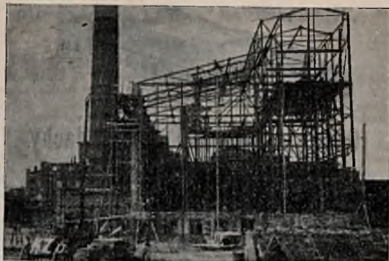
Fragment konstrukcji żel. wykonanej w elektrowni cukrowni w Szamotułach.
