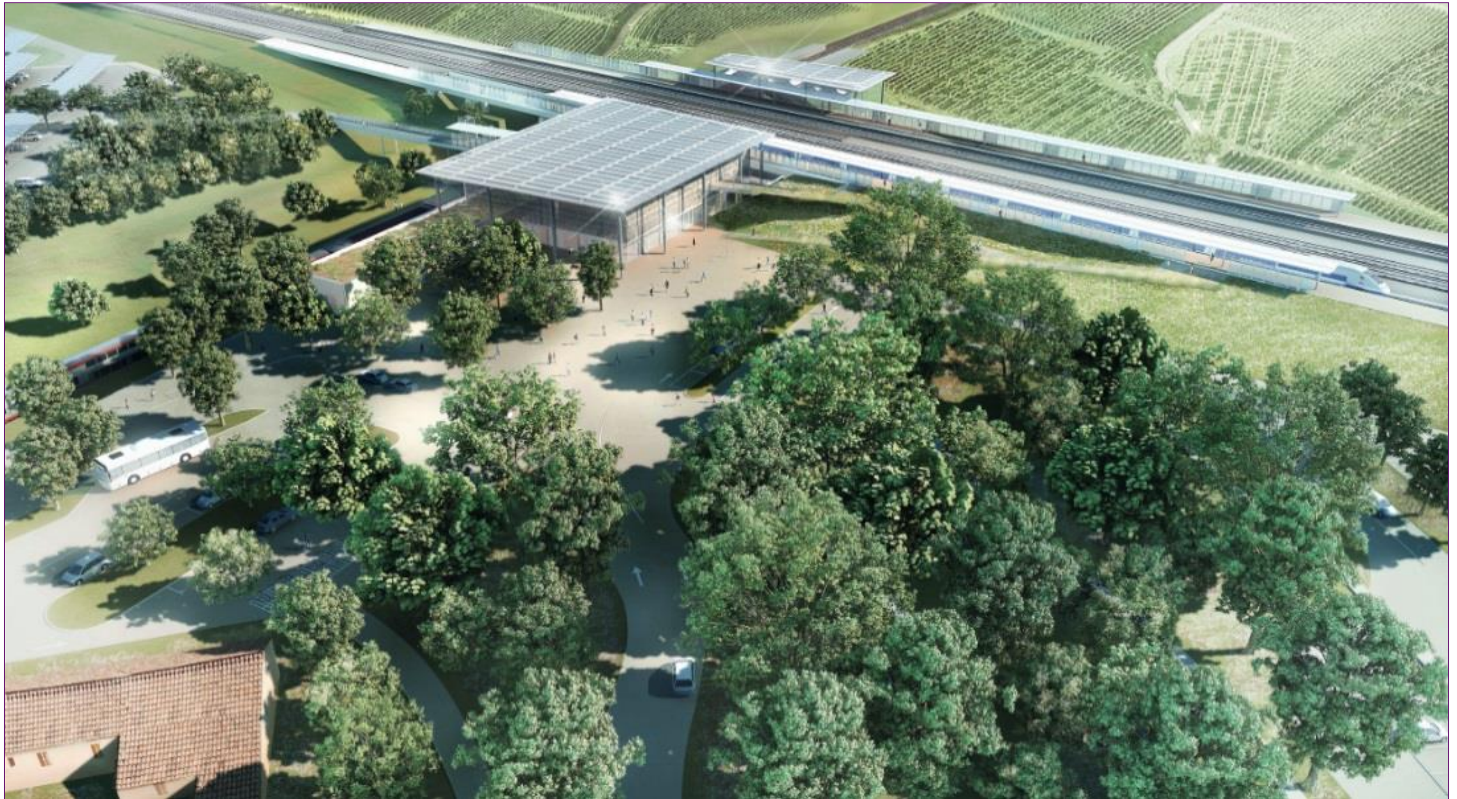
Figure 10: Vue aérienne du bâtiment voyageurs (façades) (—source : Photomontage prévisionnel - APD – Notice descriptive architecturale – Février 2016)
