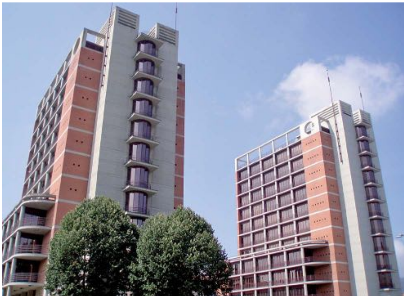
Egungo bulegoak, Errotaburu pasealekuko 1 zenbakiko 2. eta 6. solairuetan. Donostia.
