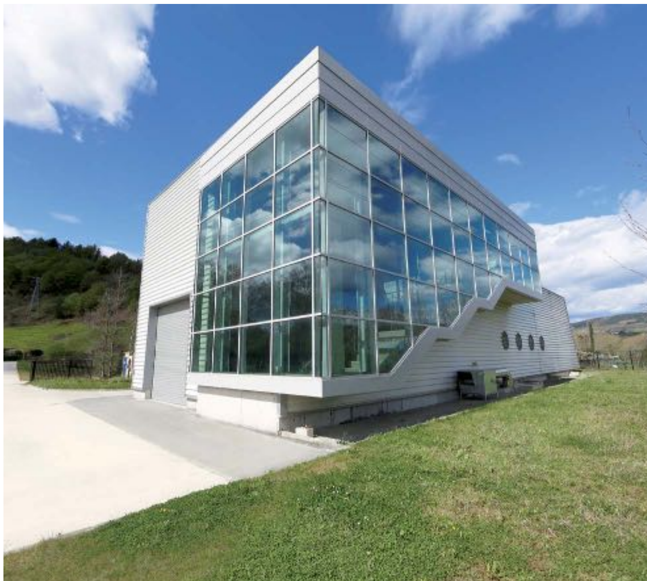
Zubietako ponpaketa estazioa, Usurbilgo eta Lasarteko hondakin urak biltzen dituena. Estación de bombeo de Zubieta que recoge las aguas residuales de Usurbil y Lasarte-Oria.
