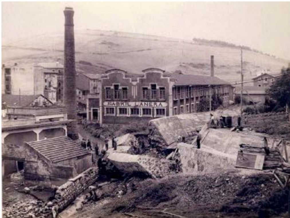
Errenteriako Lino Ehun-fabrika (1954). ERRENTERIAKO ARTXIBOA / FEDERICO SCHNEIDHOFER
