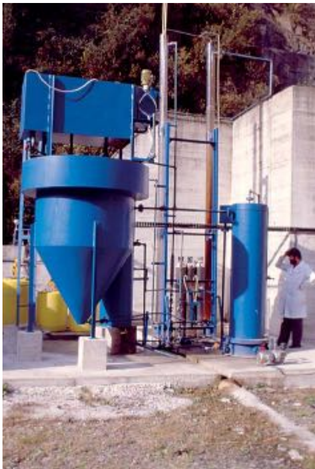
Urtegiko uraren kalitatea aztertzeko presan instalatutako planta pilotua (1987-89). KUTXATEKA / PELLO LÓPEZ
