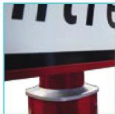
Collerette. Jonction de mât à rehausse.
