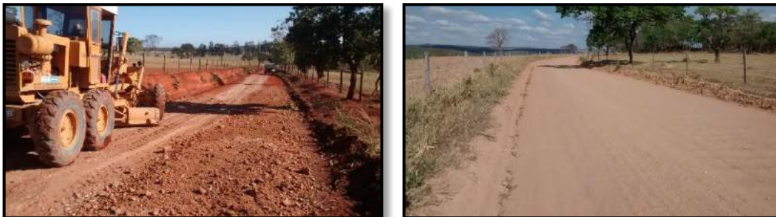
Figura 10: Adequação de Estradas.
