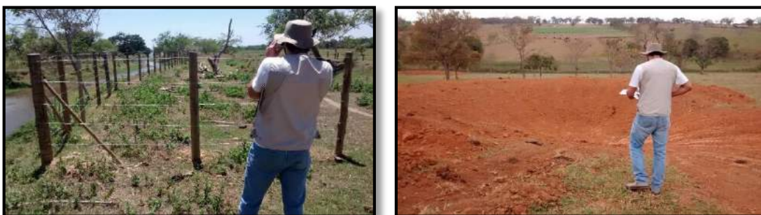
Figura 6: Fiscalização das obras.
