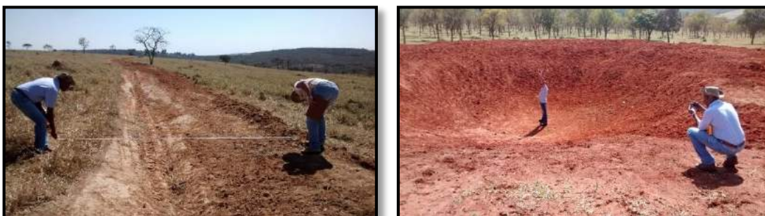
Figura 5: Supervisão das obras.
