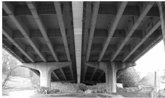
Figure 1. Viaduc instrumenté de Roberval sur l'autoroute A1, près de Senlis.
