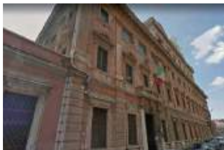
Fig. 1: Veduta generale del prospetto dell'edificio oggetto di indagini
