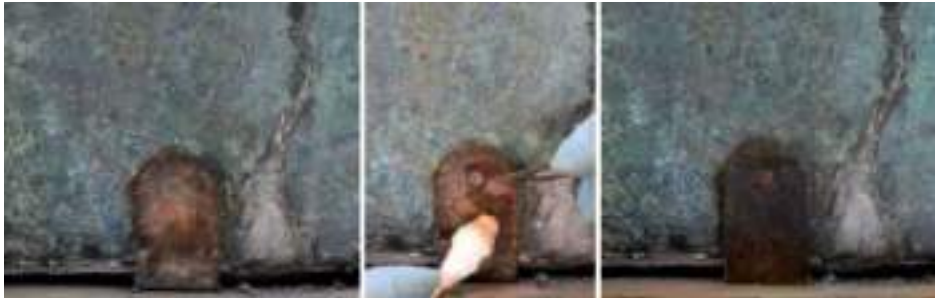
Fig. 14 - Esempio di pulitura meccanica a bisturi di una delle grappe in ferro, prima (sinistra), durante (centro) e dopo (destra).
