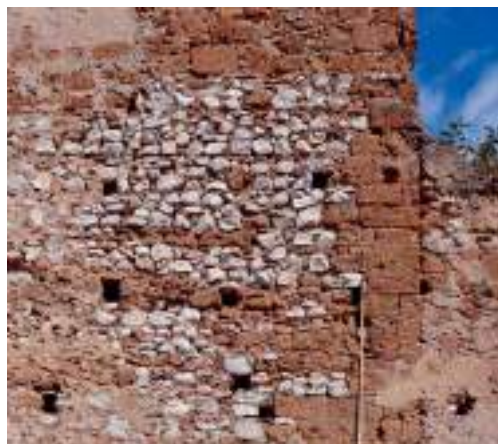
Fig. 2 - Maddaloni, rocca, donjon , porzione della fronte sud-ovest.
