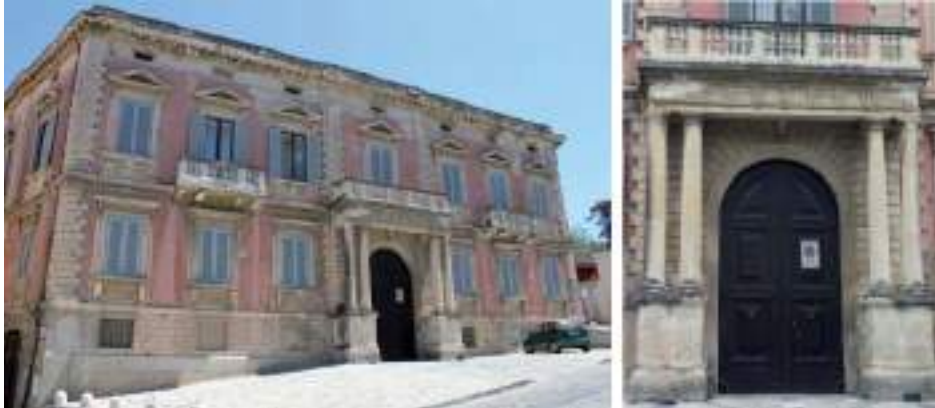
Fig. 4 - Vista d'insieme del prospetto principale e portico d'accesso
