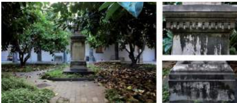
Fig. 3, 4, 5: a sinistra, le condizioni del cortile prima degli interventi conservativi, settembre 2018; a destra: il biofilm morfologicamente differenziato nella parte superiore ed inferiore del piedistallo marmoreo.
