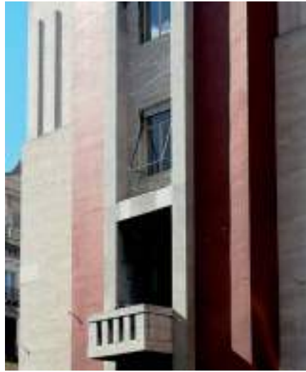
Casa del Fascio a Torretta
