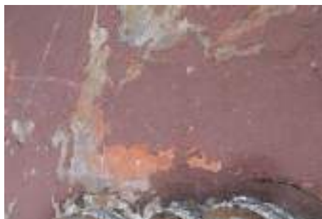
Fig. 2: Particolare della superficie delle specchiature caratterizzate da distacco della pellicola pittorica
