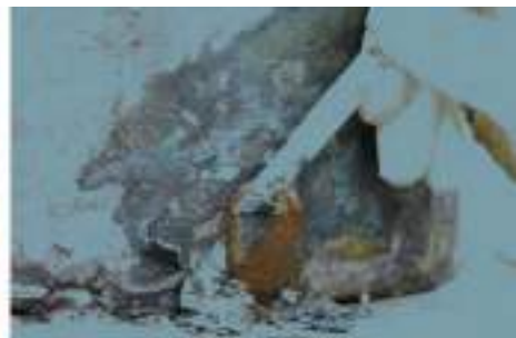
Fig. 16 - Rimozione meccanica del gesso pigmentato che nascondeva le grappe in ferro.
