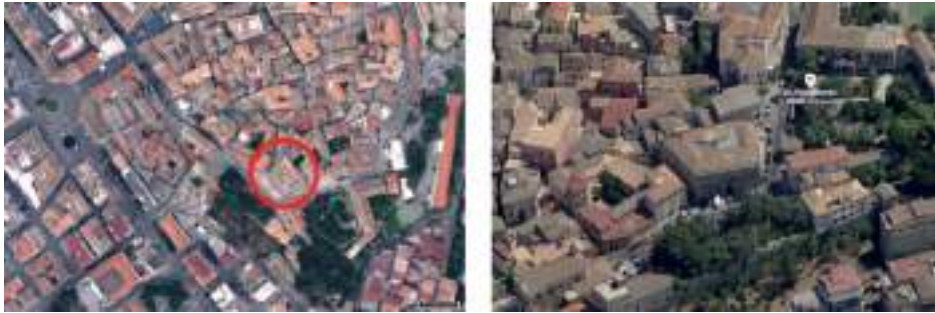
Fig. 3 - Veduta aerea e visuale 3D
