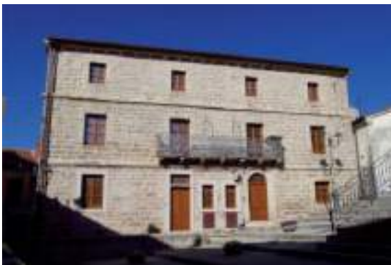
Fig. 3: Esempio di una architettura armonica nel suo impianto originale
