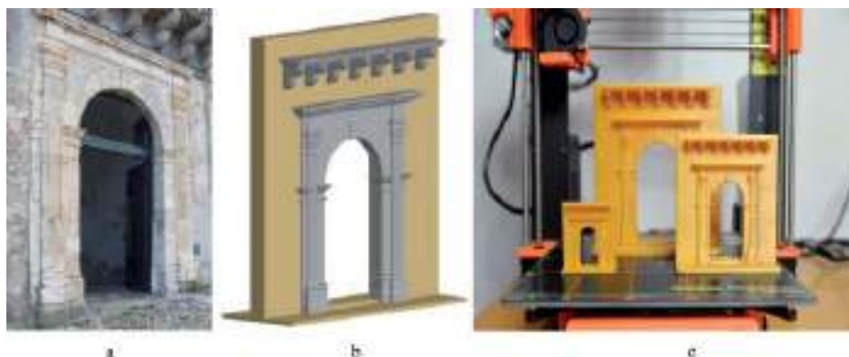
Figura 7 – a) portale di Palazzo Mirabelli; b) assonometria STL; c) modelli in PLA;
