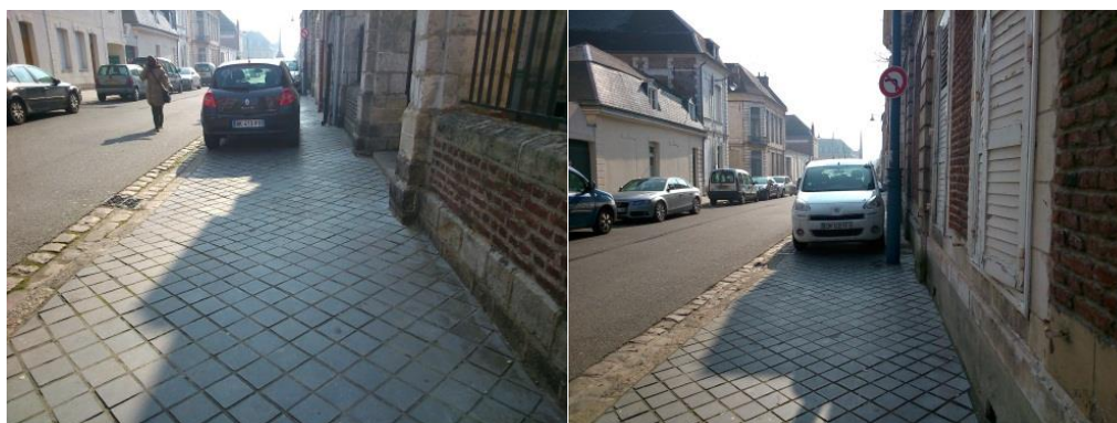
Exemples de stationnements illicites qui pénalisent la continuité et la sécurité des cheminements piétons
