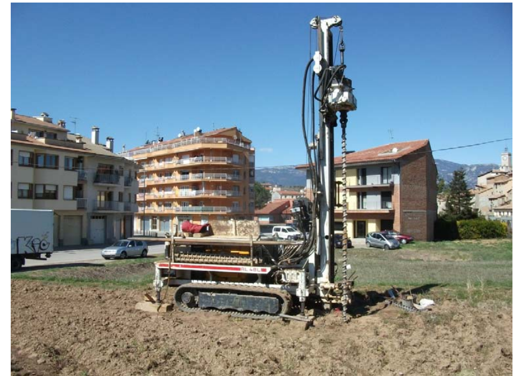
Fig. 4. Vista del solar i emplaçament del primer sondeig en la part superior del talús
