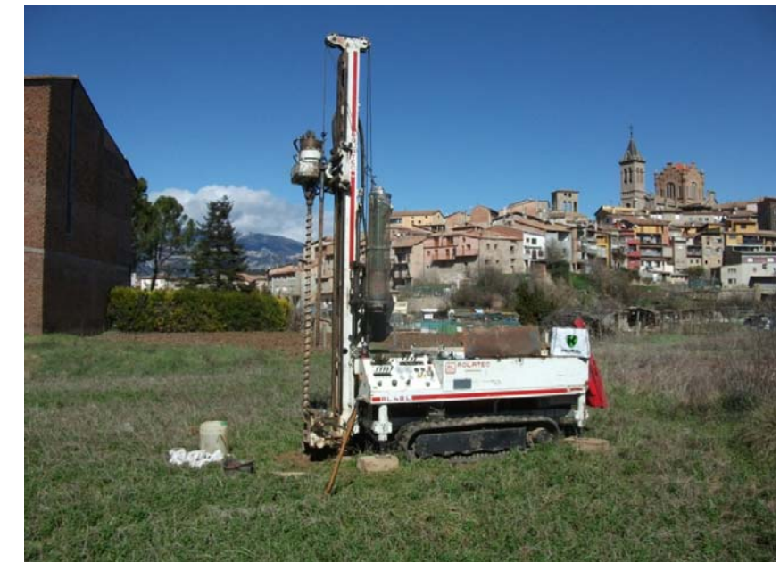
Fotos 4. Emplaçament del quart sondeig on apareix nivell freàtic a -2,5m.
