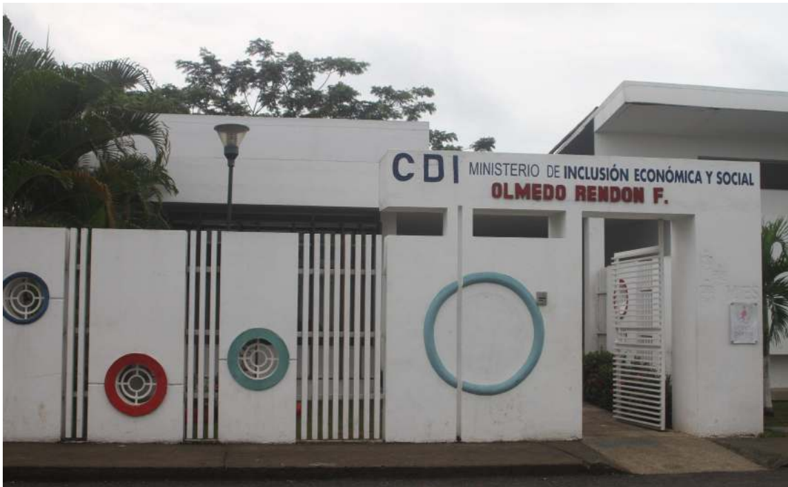
Visita técnica a las instalaciones del CDI Olmedo Rendón F.
