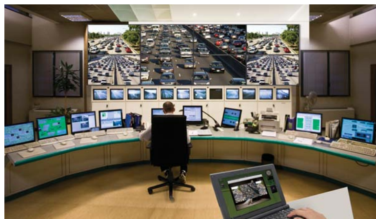
Sala de controlo
