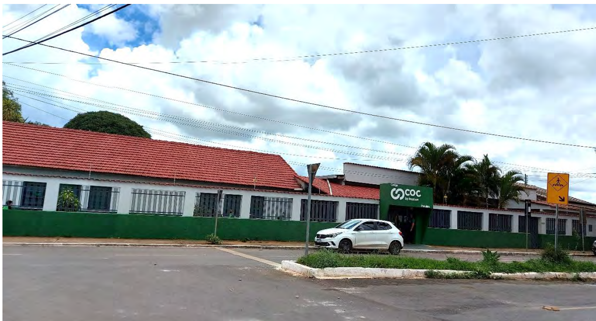
Figura 171 - Colégio COC – Unidade Planaltina na AID do empreendimento. Fotografia: Paranoá Consultoria e Planejamento Ambiental
