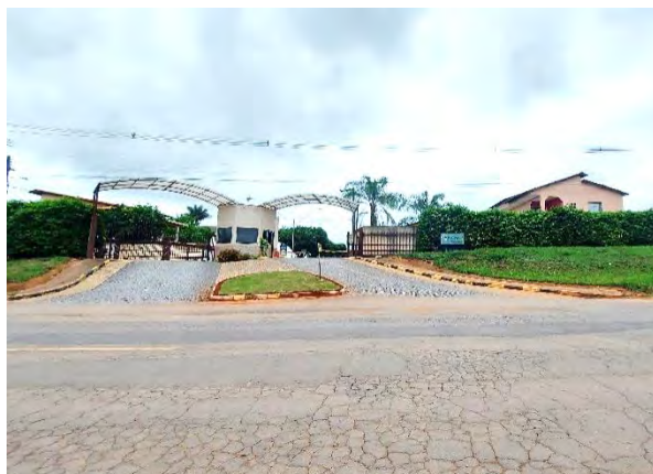
Figura 157 - Residencial Sarandi, localizado ao norte do empreendimento. Fotografia: Paranoá Consultoria e Planejamento Ambiental
