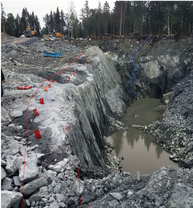
Figur 10. Bild på kvartsgången (mellan röda linjer) vid Fäbodtjärn sett från norr, med stupning åt höger i bilden. Foto från provbrytning år 2017.
