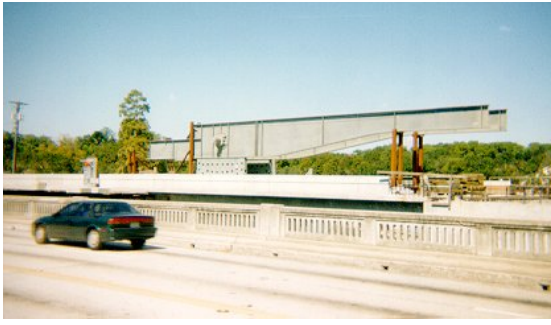
Figure 1 Trunnion-Hub-Girder (THG) assembly (mafsal-yuva-kiriş işlemleri).
