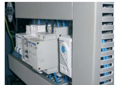
Ventiladores y carga secuencial en dos circuitos, con termostato y reloj
