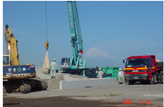
図-7 製造状況 (セメント投入)
