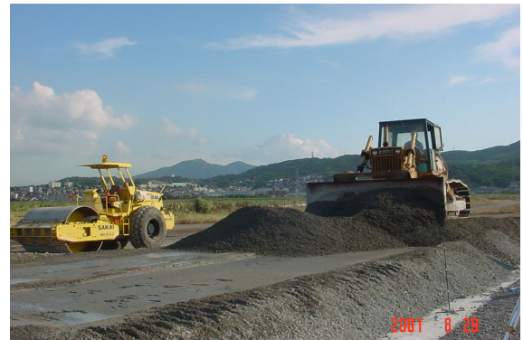
図-9 敷均し状況
