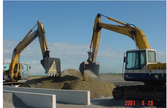
図-8 製造状況 (攪拌)
