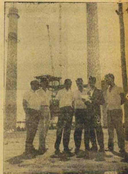
— Frágante da visita do Engenheiro Venerando Vargas, Diretor da CPCAN, as obras da SOTELCA.
