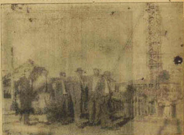
Aspecto da visita de parlamentares catarinenses, às obras da SOTELCA — 12-1-62
