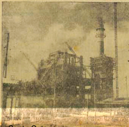
— Vista dos Silos de Carvão.
