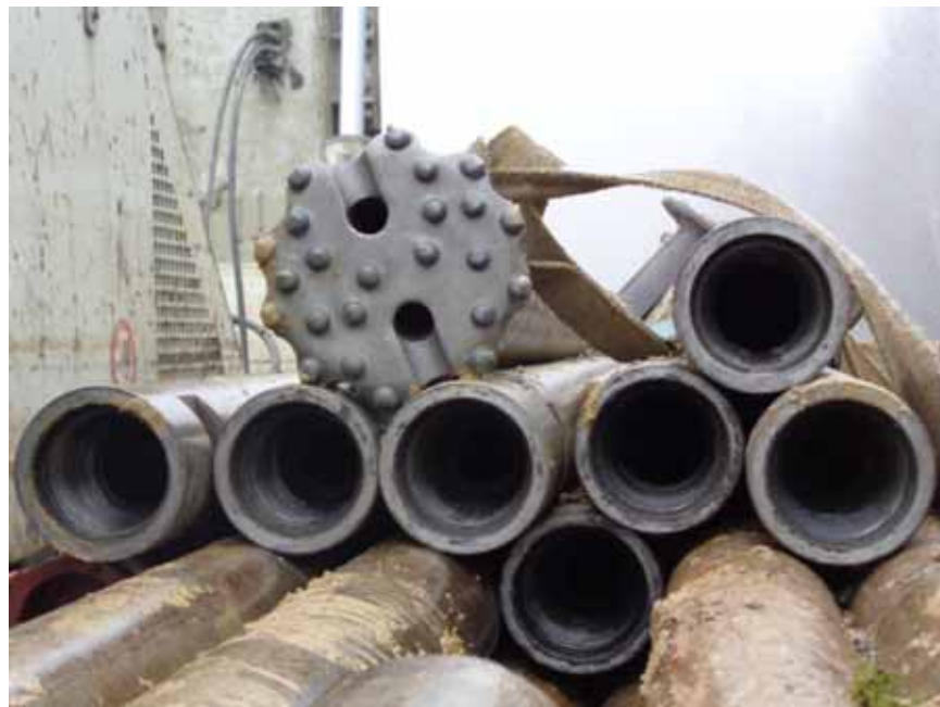
Photo 2 - Taillant et tubes de forage
