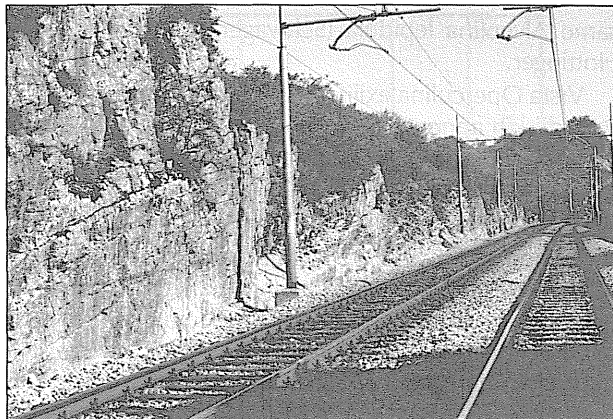
Slika 4: Pogled od točke 340 proti točki 140. Dobro je viden stopničast relief zaradi menjavanja trših in mehkejših sedimentov v vrhnjem delu apnenecv.
