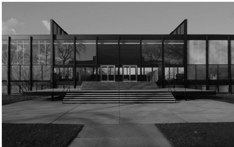
Fig. 18. Crown Hall (1950-1956) de Mies van der Rohe. Chicago.
