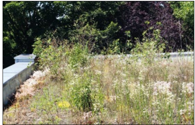
Abb. 16: Dachfläche mit Gehölzen und artenreicher Krautschicht Foto: Gregor Auinger
