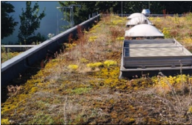
Abb. 15: Dachfläche mit artenreicher Krautschicht Foto: Gregor Auinger
