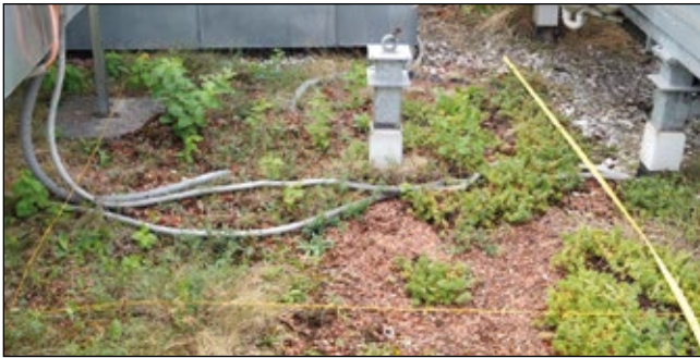
Abb. 13: Fläche zwischen den Aufbauten der Gebäudekühl- vorrichtung auf demselben Dach wie Abbildung 12 Foto: Gregor Auinger
