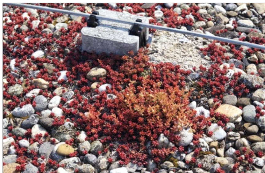
Abb. 4: Weißer Mauerpfeffer ( Sedum album ) auf einem Kiesdach. Foto: Gregor Auinger
