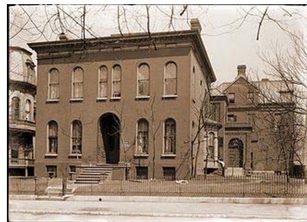
Engelmanns Wohnhaus in St. Louis (Aufnahme von 1906)
