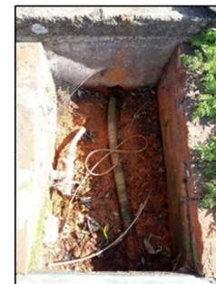
Regard d'eau potable (principe de surverse)
