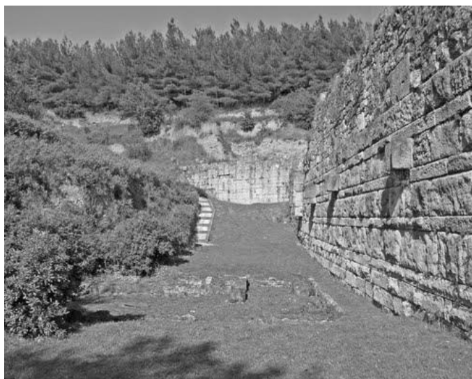
Fig.2. Aperçu du long mur nord
