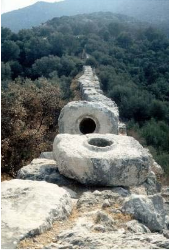
Le grand siphon de Patara (Turquie), avec tuyauterie en pierre. Photo : J.C. Litaudon.
