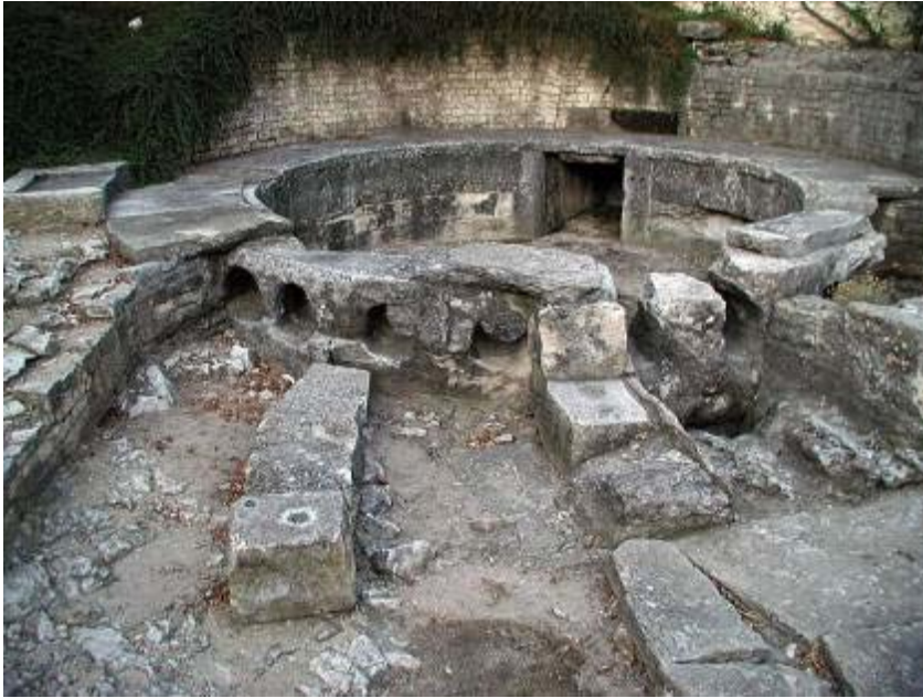
Chambre de distribution du castellum aque de Nemeasus (Nîmes). Les orifices calibrés distribuient l'eau courante aux différents quartiers de la ville romaine.
