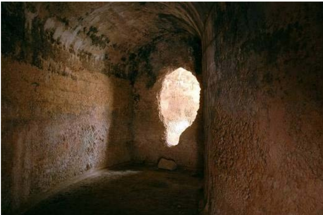
Chambre de la grande citerne de Vxama (El Burgo de Osma-Soria), construite en béton ( opus caementicium ) en forme semi-circulaire.
