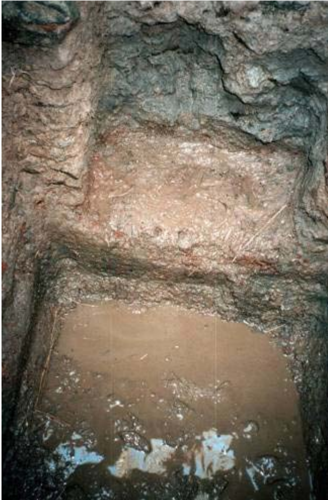
Détail du bassin de decantation, ou bassin de sédimentation, d'un des puits de regard de l'aqueduc du Gier (Lyon). Phot : J.C. Litaudon.
