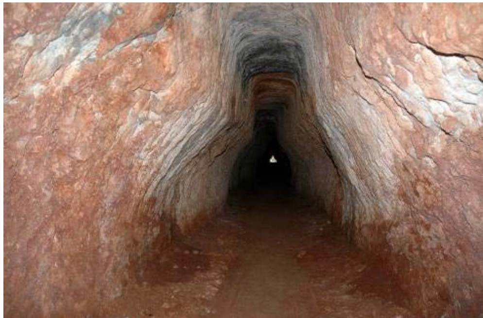
Canal en galerie souterraine creusé profondément dans la roche. Aqueduc de Vxama (Soria).
