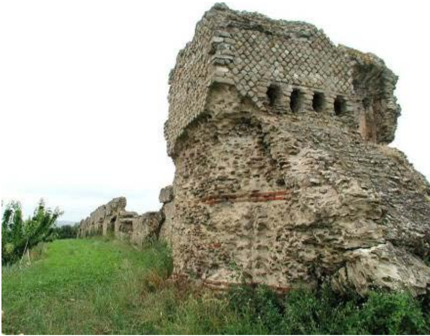
Réservoir de chasse (amont) de l'aqueduc du Gier à Soucieu-en-Jarrest, au lieu-dit "la Gerle", avec les orifices et la rampe d'appui des tuyaux de plomb qui s'appuyaient sur un rampant.
