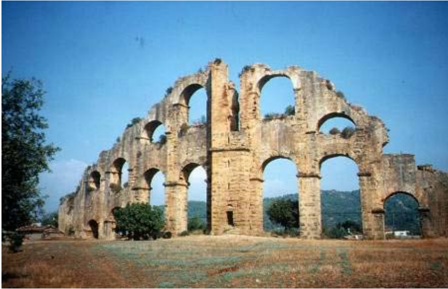
Tour de décharge de pression de l'Aqueduc d'Aspendos (Turquie). Photo: J.C. Litaudon.
