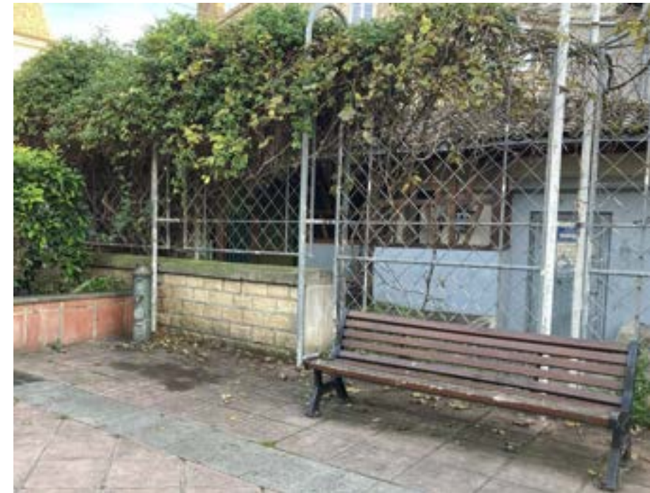
Muret existant conservé et prolongé + pose de clôture en serrurerie
