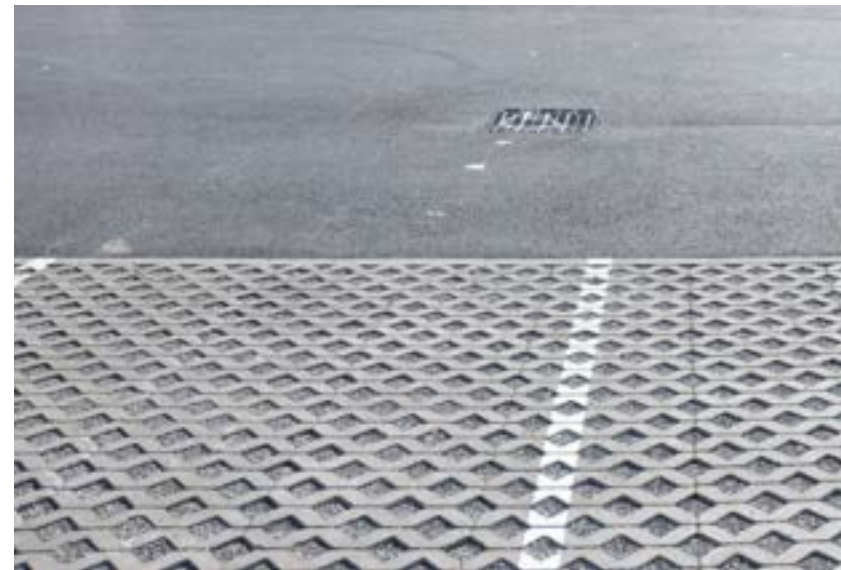
Dalle alvéolaire béton + gravier sur stationnement
