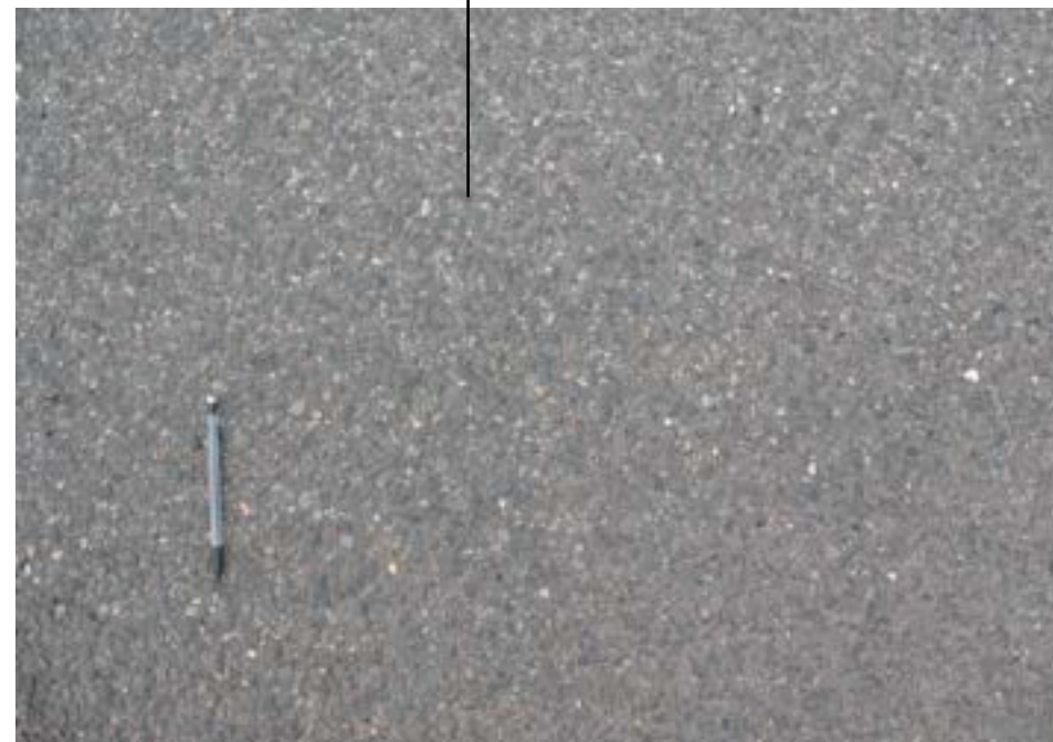
Enrobé sur chaussée et stationnement
