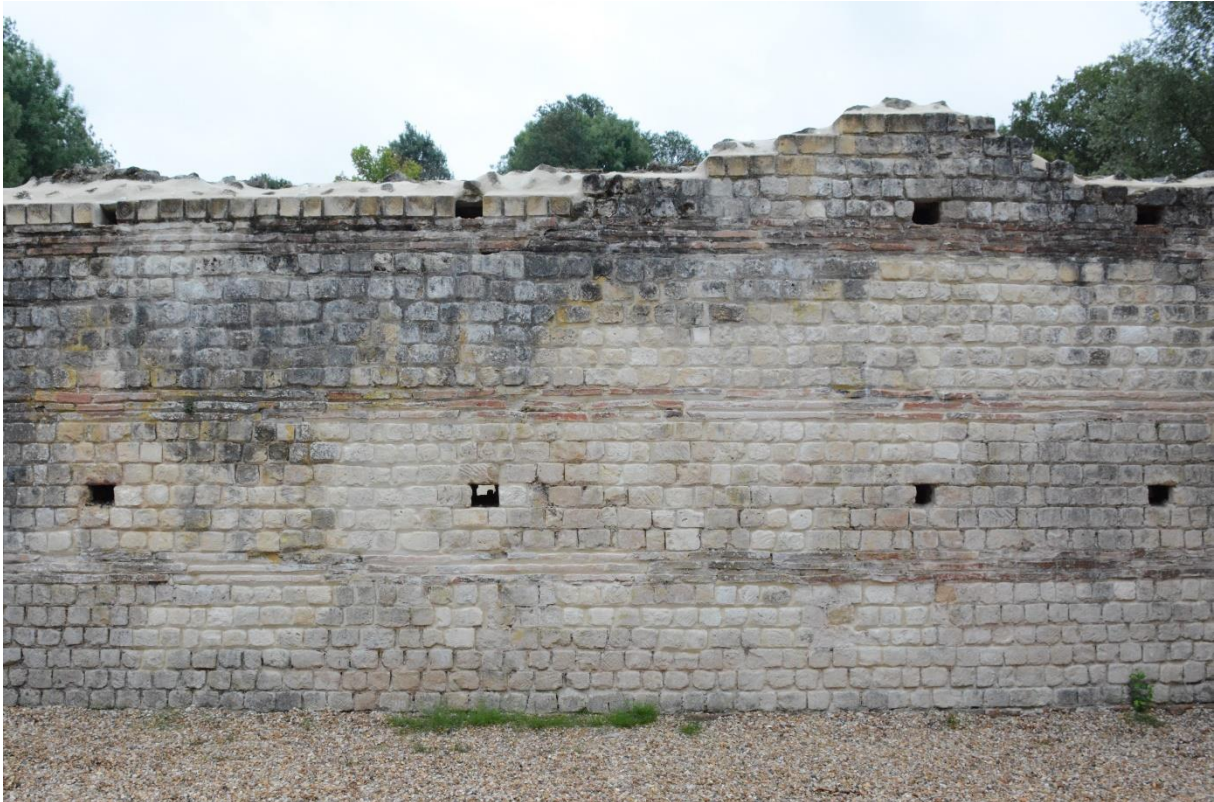
Figure 10 : Exemple de construction d'un mur suivant la technique de opus vittatum mixtum (mur sud du Temple).
