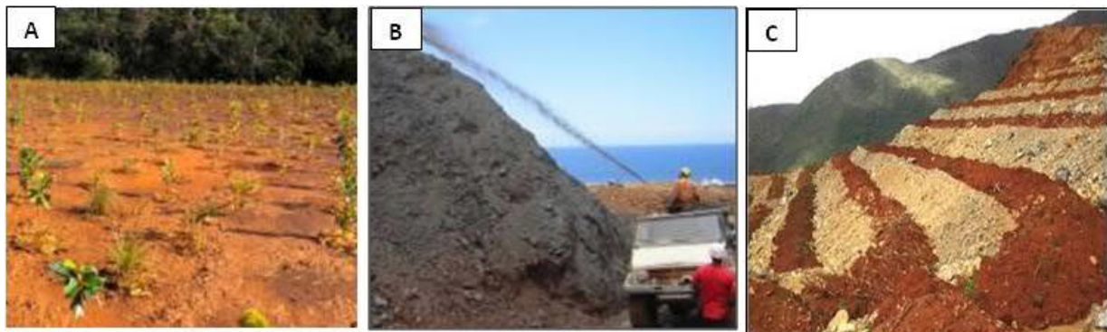
Figure 1.1. A) technique de plantation sur zone dénudée (source: SIRAS pacifique), B ) technique d'ensemencement hydraulique sur une verse de stériles minier (source: SIRAS pacifique), C) Topsoil étalé sur une verse de stériles minier (Source: IAC).
