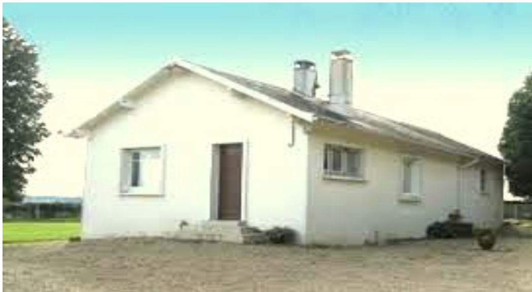
Maison de Samuel Beckett à Ussy-sur-Marne. D.R.
