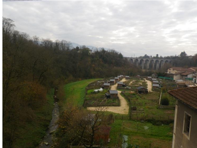
Le vallon de la Cumane, au loin, le pont de la voie ferrée
