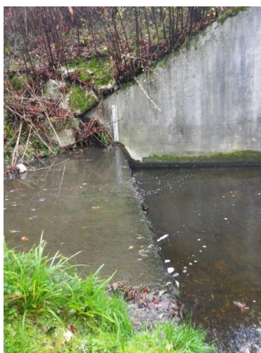
Petit seuil sur la Cumane (< 1 m de haut) à l'amont de l'autoroute
