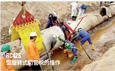
RC42S 型旋转式切管机的操作
