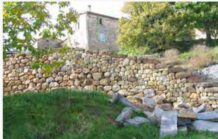
Mur de soutènement réalisé en grès chez un particulier à PLANZOLLES – apport des matériaux par LEYRIS
