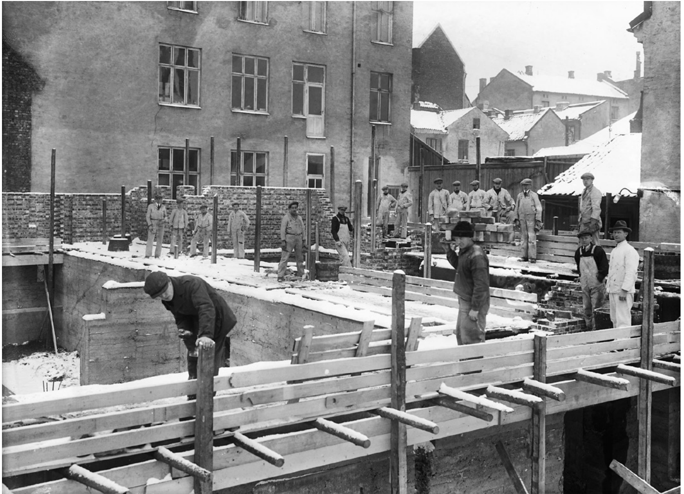
Bygningsarbeidere på byggeplass i byen, 1920-årene.
