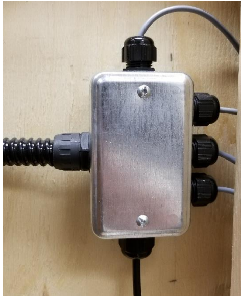
Figure 21: Boîte de jonction des périphériques d'entrée
