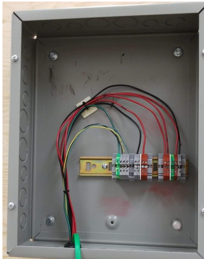
Figure 16: Assemblage interne du panneau frontal
