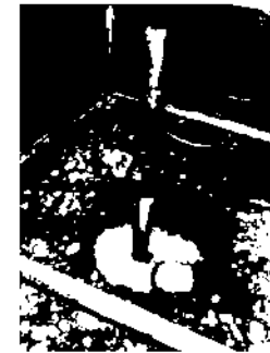
No.1-4孔口状況 (8/27夜間作業にて撮影) 地下水と混ざった薬液 (白色)がNo.1-4孔口ま で上昇
