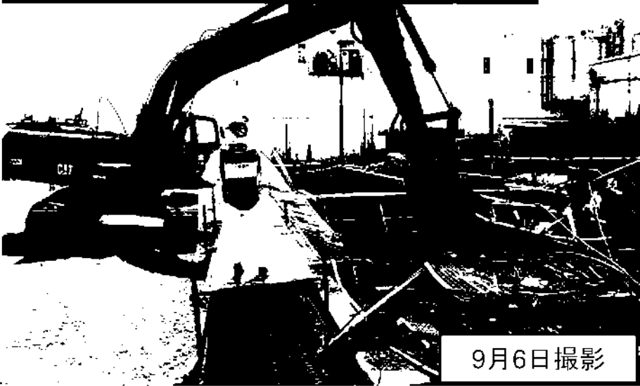
10m盤 逆洗弁ピット瓦礫撤去状況
